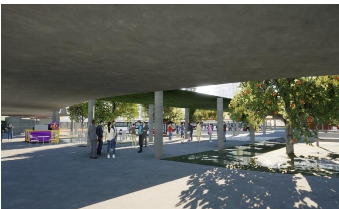
Figura 06 – Vista a partir do módulo 3 do Terminal
